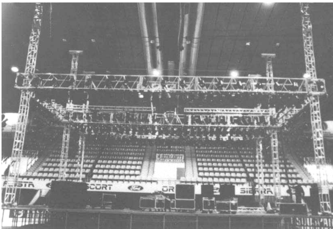
Hình 14.07: Tháp Thomas với giàn khung hộp.
