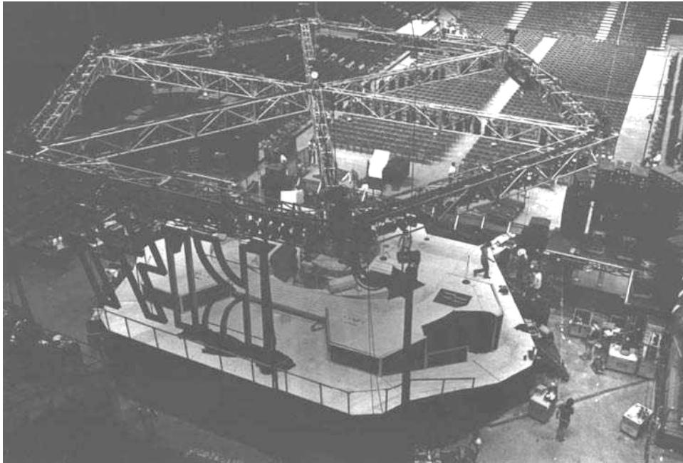
Hình 13.10: Giàn khung lưới hình lục giác (Hexagon)
