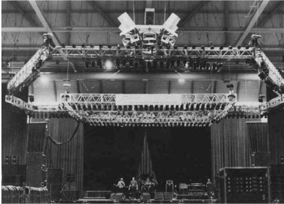
Hình 14.11: Treo giàn khung bằng 8 motor.
