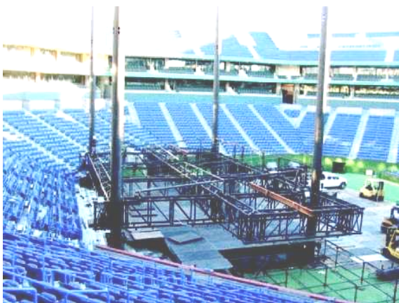
Hình 14.20: đang lắp ráp 4 trụ đứng chống mái che Hình 14.21: 4 trụ mái che cụm loa và ánh sáng
