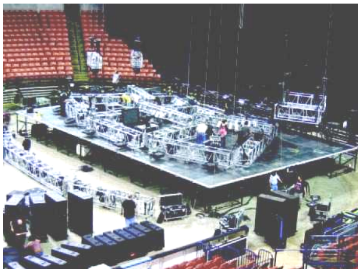
Hình 13.19: Giàn khung show Def Leppard trước khi nâng lên
