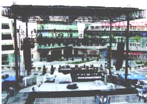
Hình 14.20: đang lắp ráp 4 trụ đứng chống mái che Hình 14.21: 4 trụ mái che cụm loa và ánh sáng
